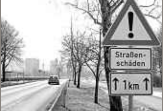
Die K 7132 erhält einen neuen Belag. Foto: Schnurr
