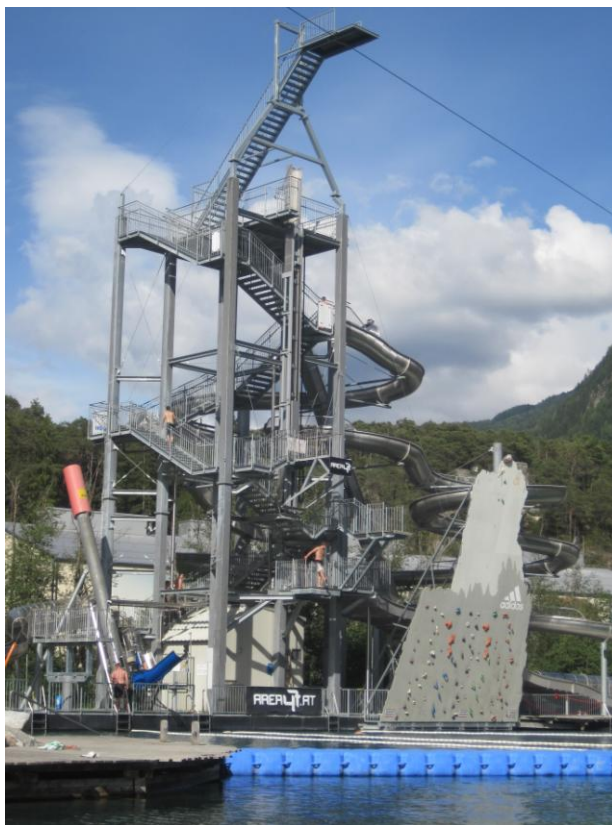
3: Sprung- und Rutschenturm in der Area47
