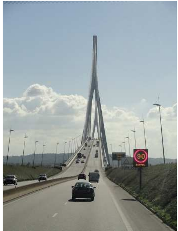
Der Pont de Normandie
